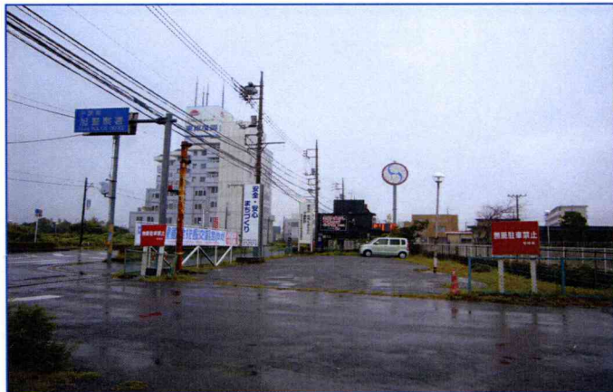
横断看板と北側支柱を撤去 終了
